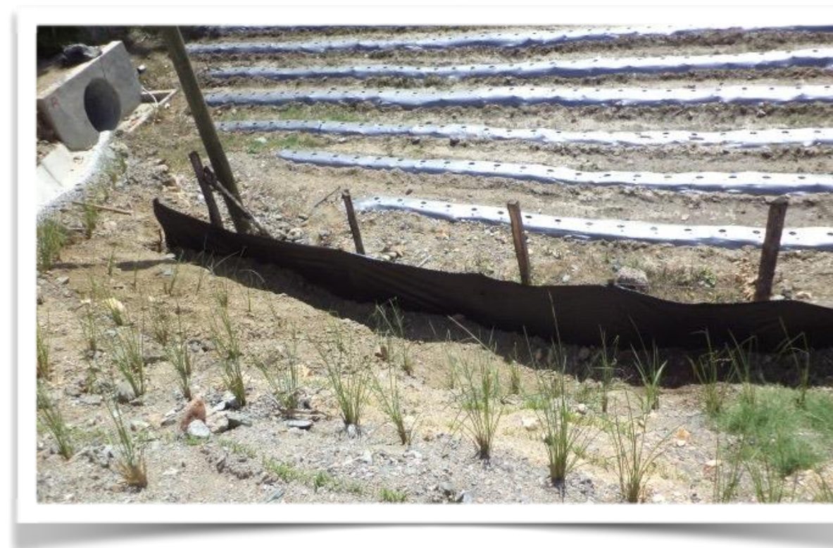
Silt Fence para reducir erosión por escorrentía
