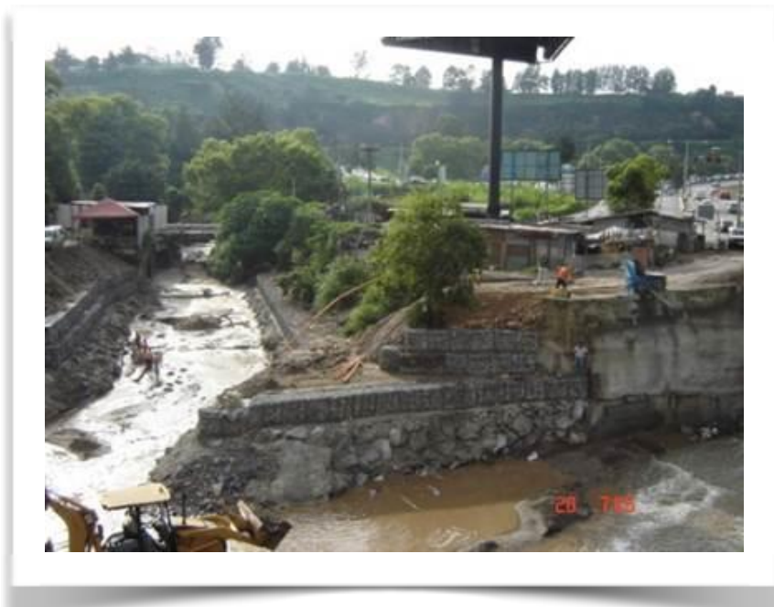
Proyecto: S-65, CA-09 Norte, Tramo: Puente Belice – Puente Rodriguitos.
