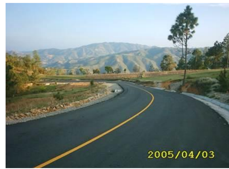
Ruta Nacional RN7W: Tramo III: Sacapulas – Aguacatán – Buenos Aires (Chiantla) Huehuetenango
