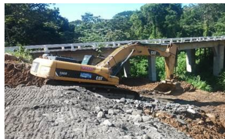
Proyecto: CA-2 Occidente Subtramo III: Puente Carmen de Mirón – Puesto de Aduana Tecún Umán
