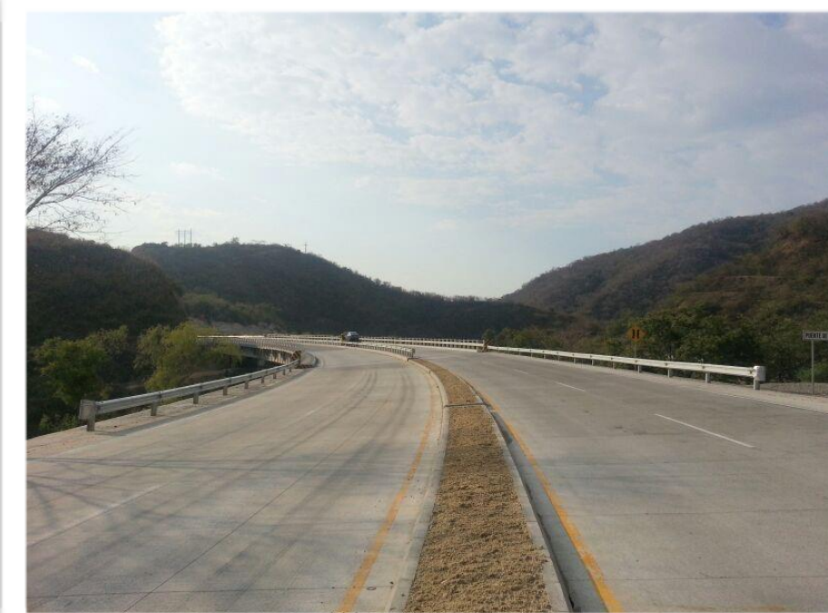
Diseño Puente La Amistad: 4 carriles, 120 m de longitud, en curva Carretera CA-9 Norte
