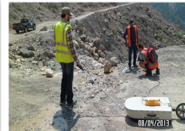
Radar de Penetración del Suelo, GPR
