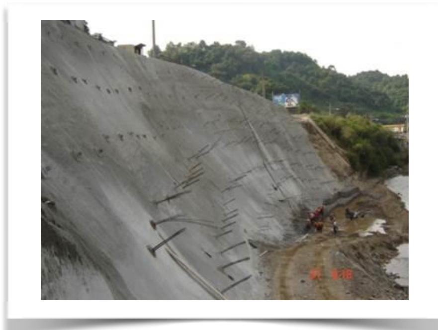
Proyecto: S-65, CA-09 Norte, Tramo: Puente Belice – Puente Rodriguitos
