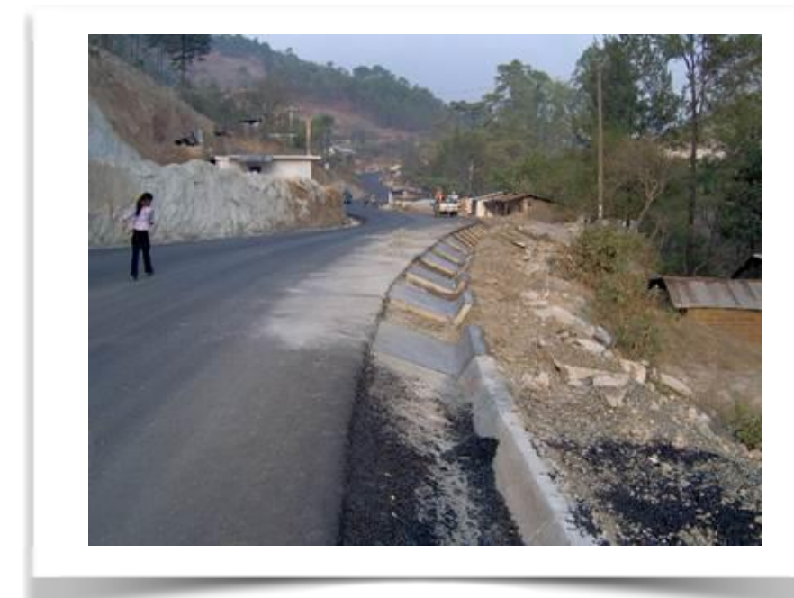
Proyecto: Rehabilitación del tramo Ixtahuacán - Cuilco
