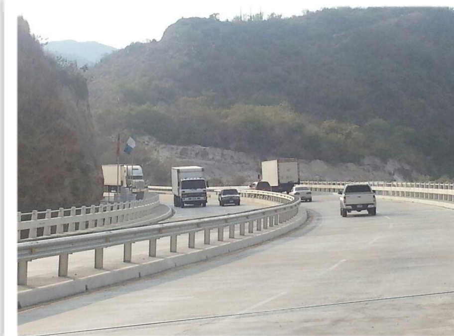
Diseño Puente La Amistad: 4 carriles, 120 m de longitud, en curva Carretera CA-9 Norte
