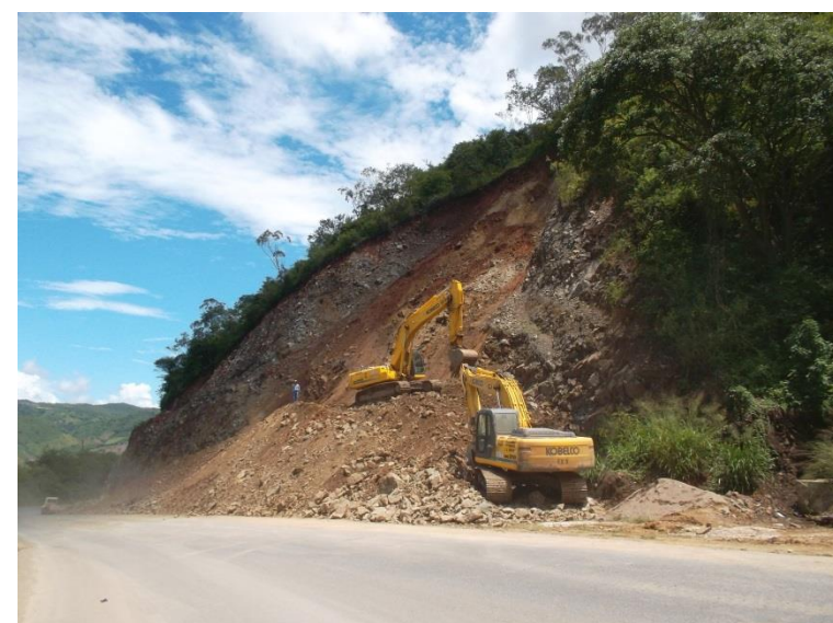
Proyecto: CA-09 NorteTramo II: Agua Caliente - Sanarate
