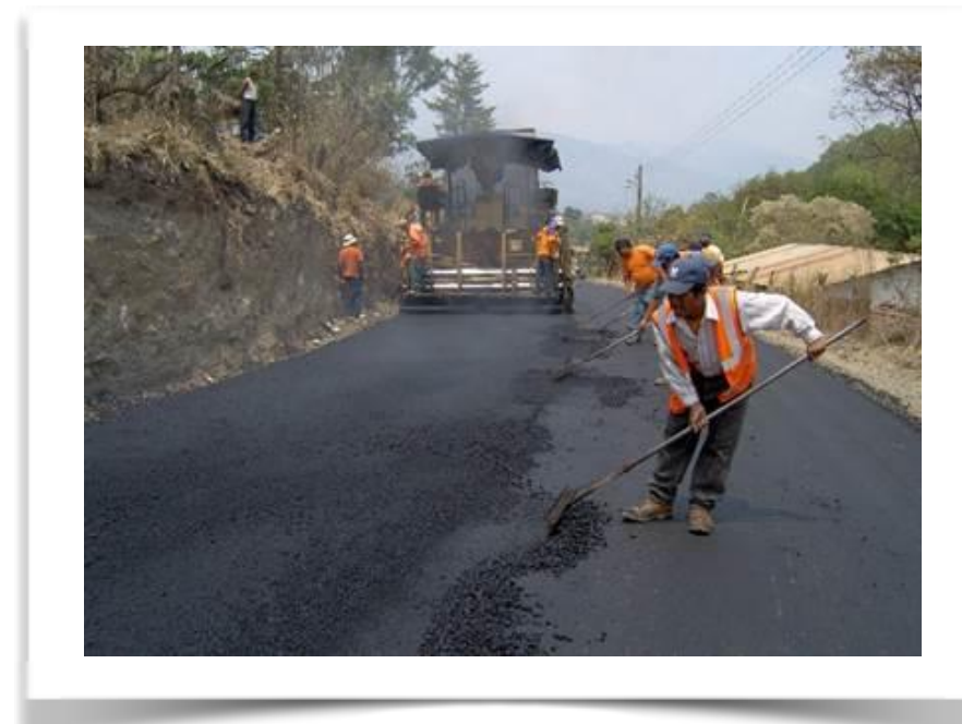
Proyecto: Rehabilitación del tramo Ixtahuacán - Cuilco
