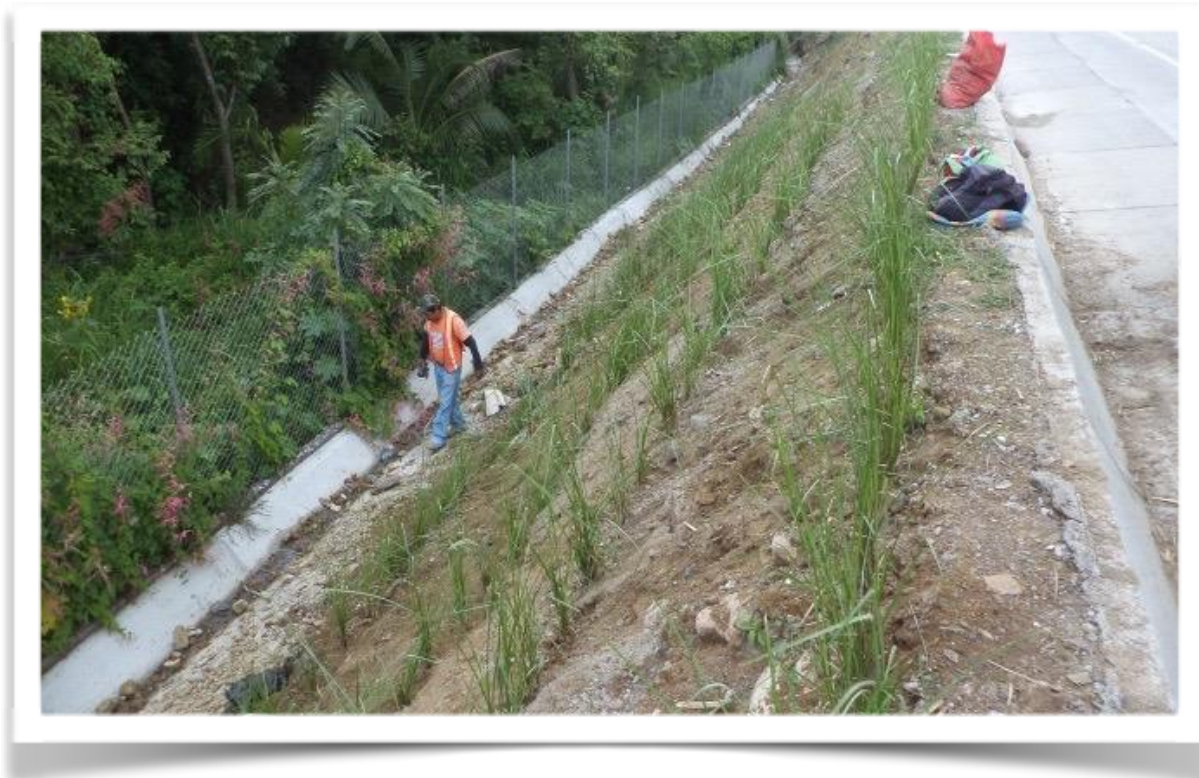
Siembra de Vetiver en terraplen
